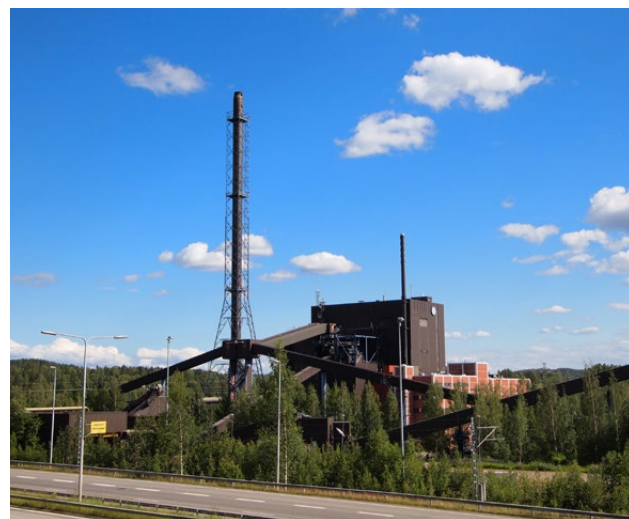
Das finnische Biomasse-Blockheizkraftwerk nutzt Condition Monitoring als Retrofit ( Bildquelle )
